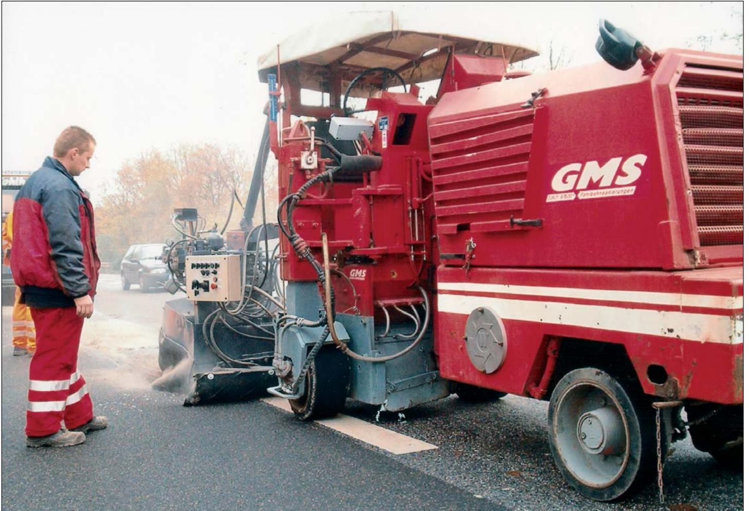
Mit dem **GMS-Road-Twister® 1000** werden Fahrbahnen aus Asphalt oder Beton mit minimalem Abtrag bearbeitet.
