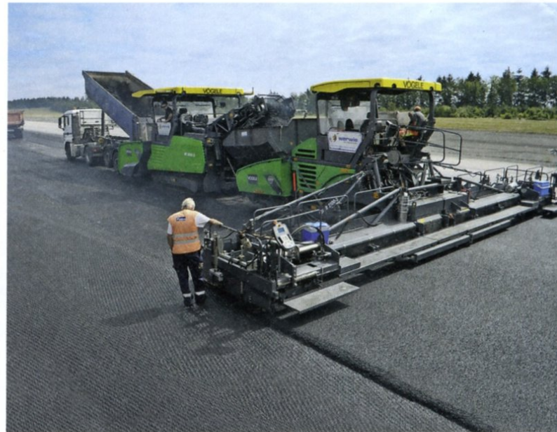
Dank flexibler Ausziehenbauteile kann auch bei starren Bohlen jede beliebige Zwischengröße realisiert werden
