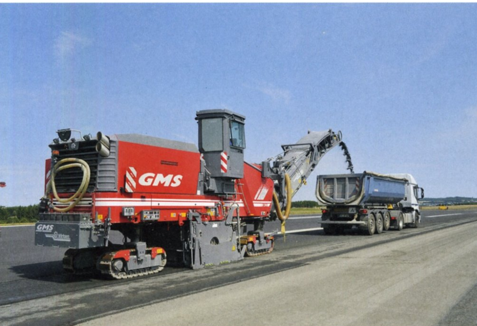
Die Kabine der Fräse lässt sich rechts wie links über die Nullkante hinausbewegen und sorgt für beste Sicht auf das Geschehen
